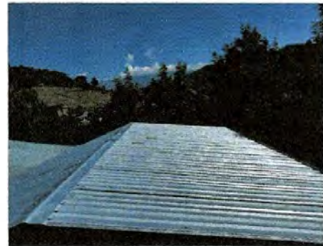
Foto 4: Techo con lámina troquelada y constaneras de metal inslatadas
