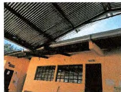
Foto 6: Canal de metal instalado
