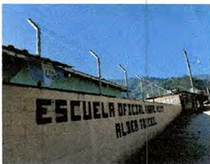
Foto 5: Malla en muro perimetral instalado
