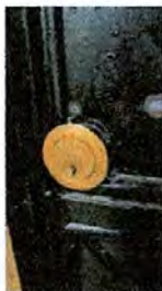
Foto 9: cambio de chapas
