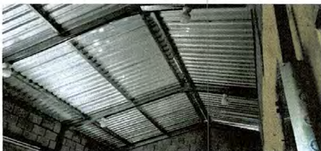
Foto 7: iluminación eléctrica instalada
