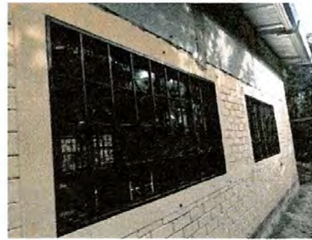
Foto 2: ventanas y balcones instalados
