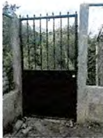
Foto 3: Portón de metal instalado
