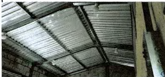
Foto 8: costaneras de metal instaladas
